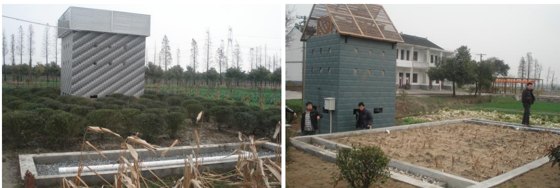
图 4-4 缺氧池-脉冲多层复合滤池-人工湿地处理技术工程实景图
