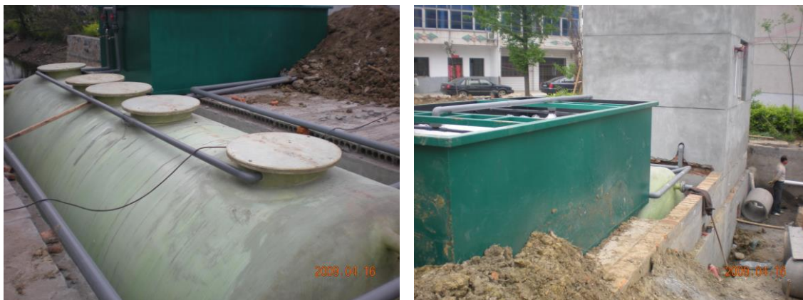
图 4-13 A/O 地埋式污水处理技术工程实景图
